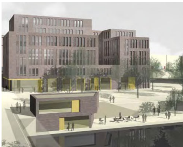
Abb. 2: "Hoheluftcontor" mit Ufer-Verbauung
